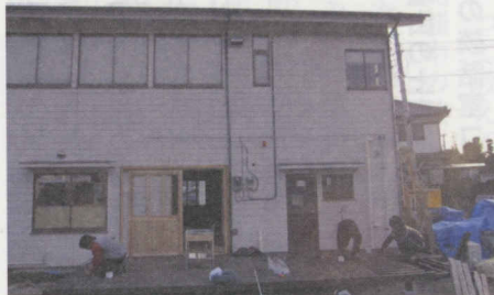
平成 24 年、コロボックル改装中の様子。
