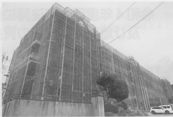
整備が進められている勝沼中学校
