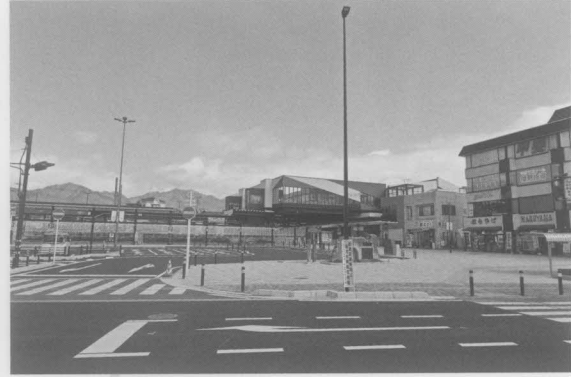
利便性が向上した塩山駅南口駅前広場
