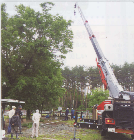
パイプ吊り上げ作業
