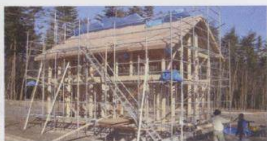
2014年 1号棟の工事
