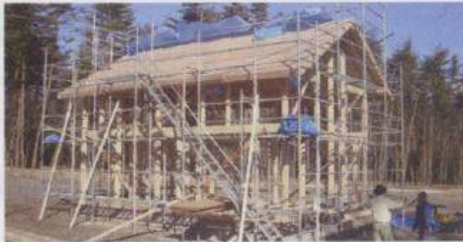
2014年 1号棟の工事
