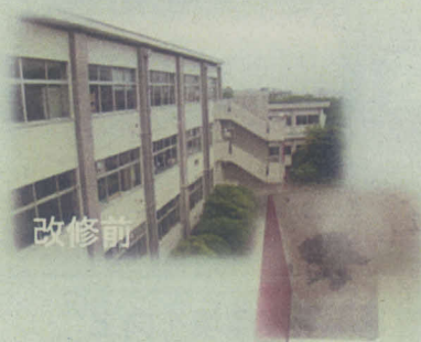
外観（北・西面）
