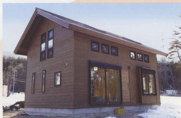
▼ 完成目の1号ロッジ(2014.3.12撮影)
