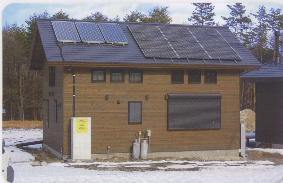
1号棟の太陽光発電パネルと太陽熱温水器
